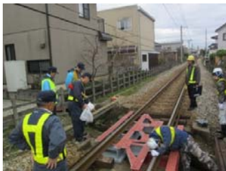
12月10日 社長巡回（穴池場橋梁）
