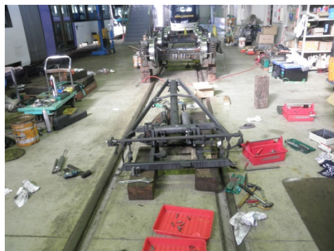
パンタグラフの分解・整備状況
