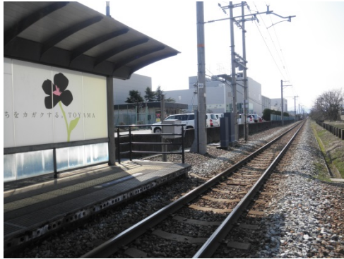
下奥井駅上り線へ閉そく信号設置予定箇所
