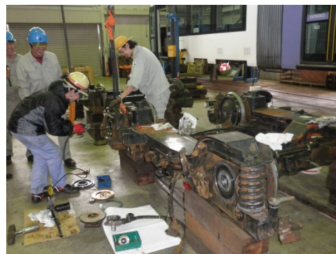
台車の整備作業状況
